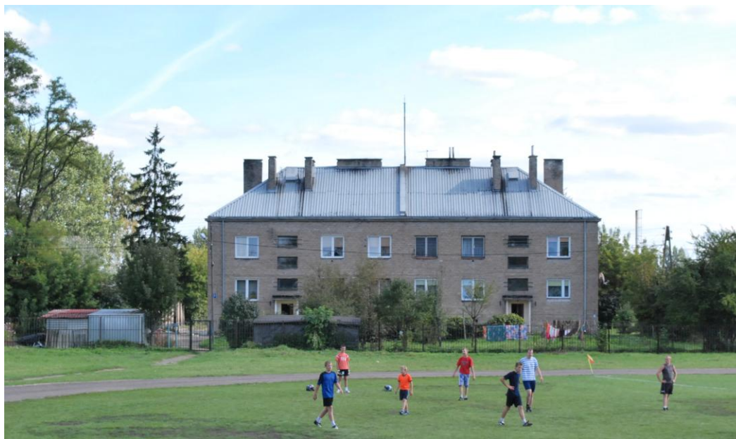
Zdjęcie 7. Budynek komunalny przeznaczony do rewitalizacji.
