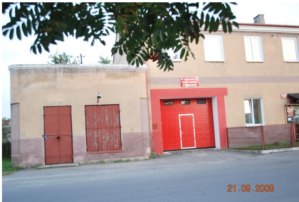
Zdjęcie 5 Budynek ochotniczej Straży Pożarnej w Bodzechowie.
