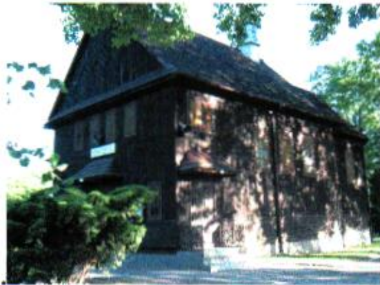
Widok od północnego – zachodu
