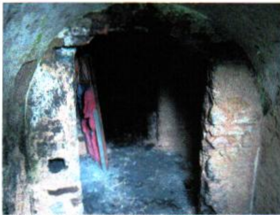
Widok wnętrza piwnicy (pierwszej przestrzeni)
