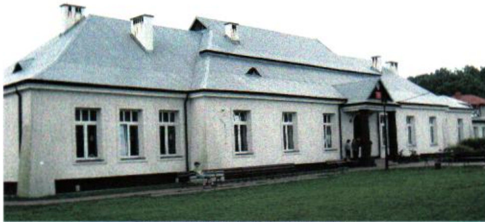
Widok elewacji frontowej (zachodniej)
