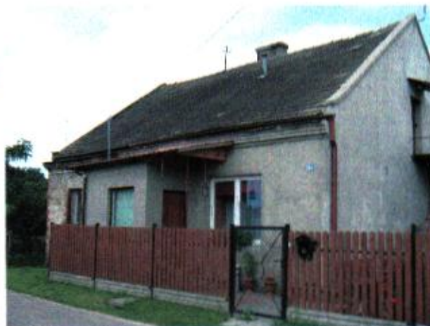
Widok od północnego – zachodu części przebudowanej
