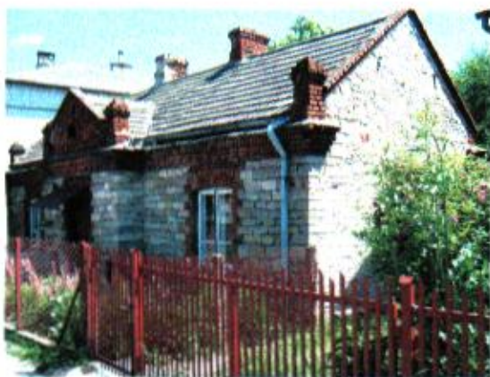
Widok elewacji frontowej (północnej)
