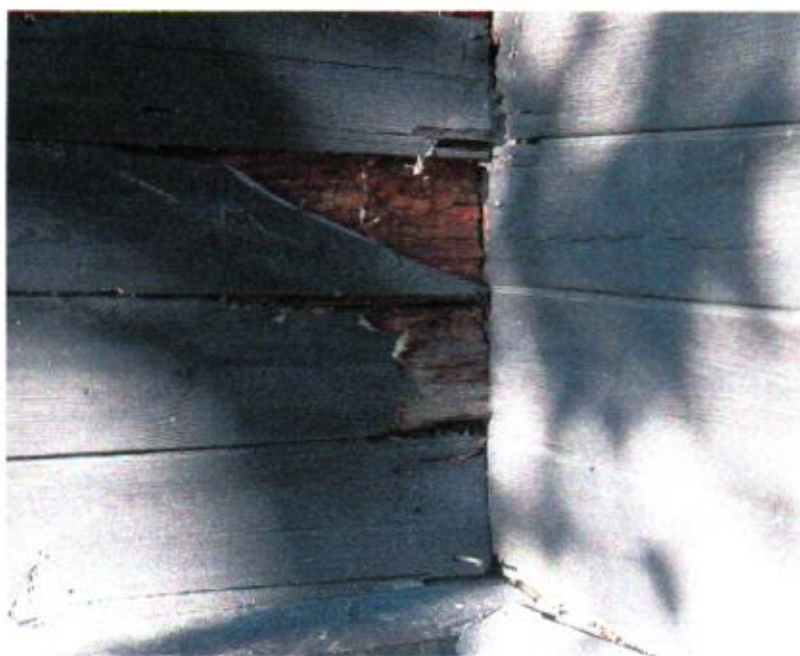
Fragment konstrukcji po odsłonięciu szalunku.
