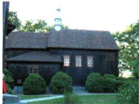
Widok elewacji wschodniej
