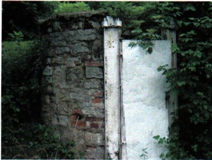
Widok piwnicy (pomieszczenia ujęcia wodnego) od wschodu.
