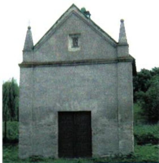
Widok elewacji frontowej (od wschodu)
