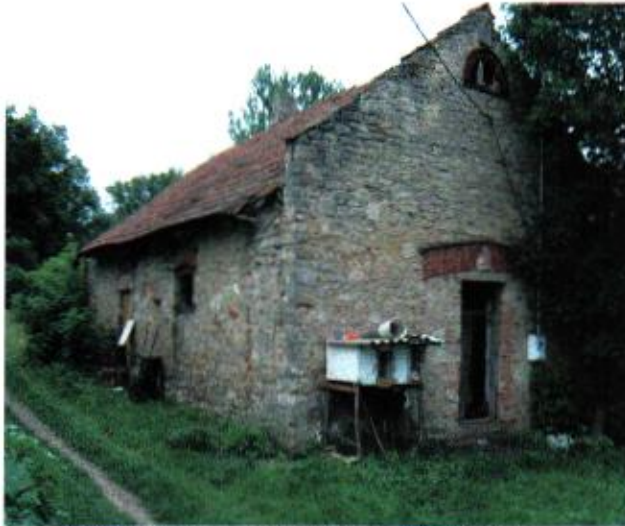
Widok od strony południowo – zachodniej
