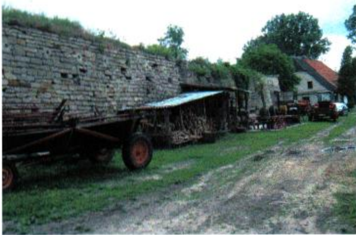
Mur oporowy dziedzińca
