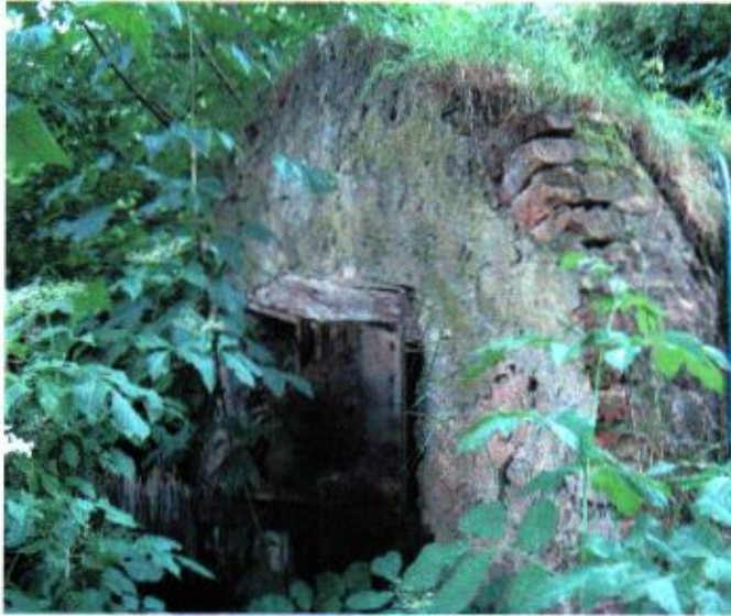
Piwnica ziemna widok od wschodu
