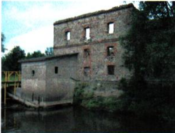
Widok pozostałości młyna
