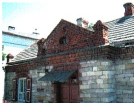
Fragment szczytu budynku na osi północnej
