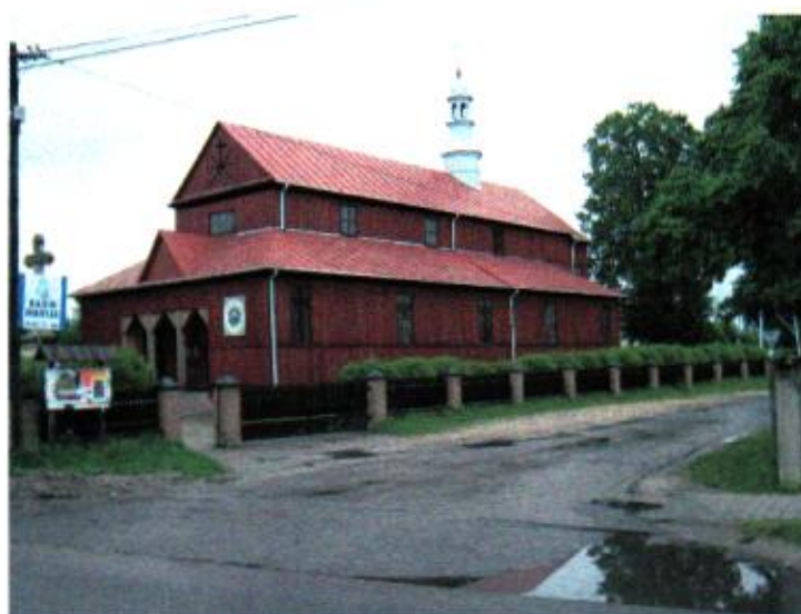
Widok od strony południowo – zachodniej
