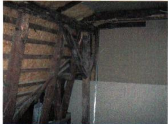
Fragment więźby dachowej mansardy
