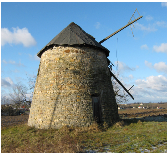
Szwarszowice wiatrak „holender” (zdjęcie przed remontem)
